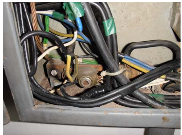
การจัดวางอุปกรณ์ควบคุมที่ไม่ได้มาตรฐาน
