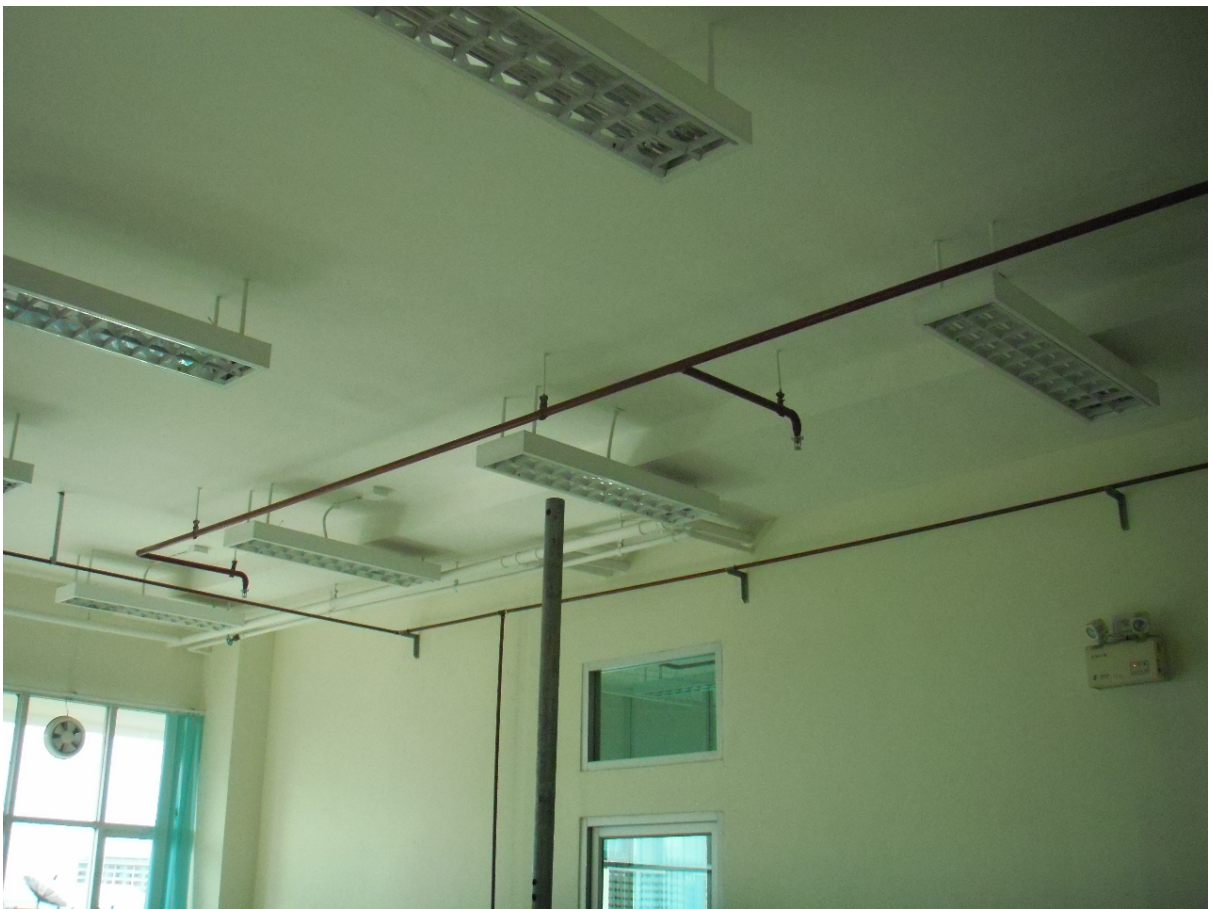
เดินท่อสปริงเกอร์
